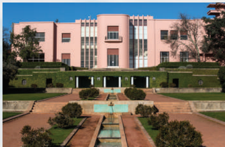
Fundação de Serralves – Porto
